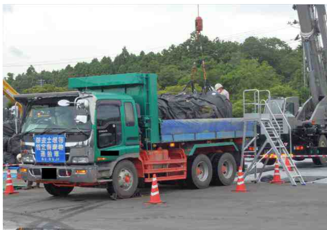
保管場作業の状況確認
