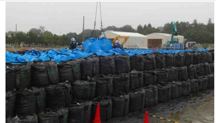
保管場への定置作業
