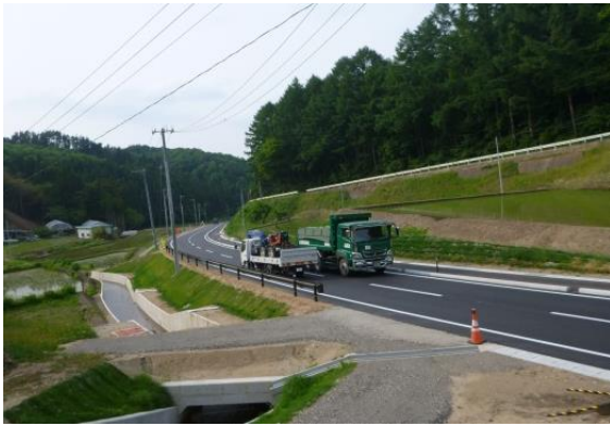
【ふくしま復興再生道路】 国道114号 小綱木バイパス(2工区)
