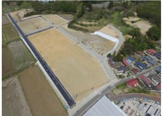
【復興公営住宅整備】 石倉団地 造成工事 H28.4月状況
