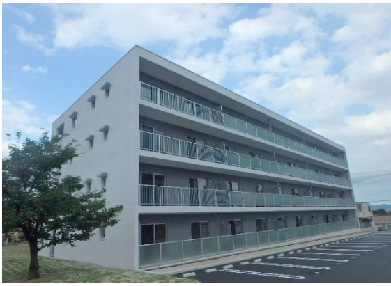
【復興公営住宅整備】 飯坂団地 H27.9完成
