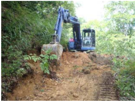
作業道の作設状況（柳津町）
