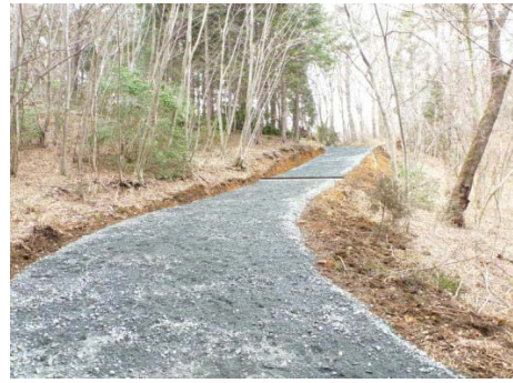
作業道の完成状況（いわき市）
