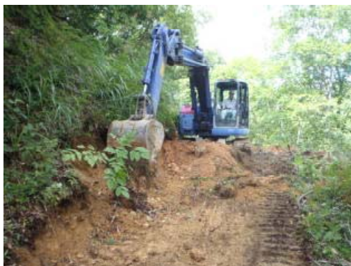
作業道の作設状況（柳津町）
