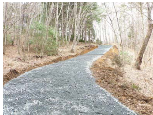
作業道の整備状況（いわき市）
