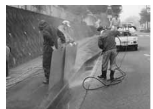
▲「除染作業」の様子
