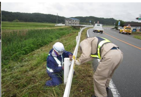
応急補修作業
