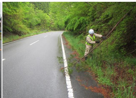
支障木撤去作業
