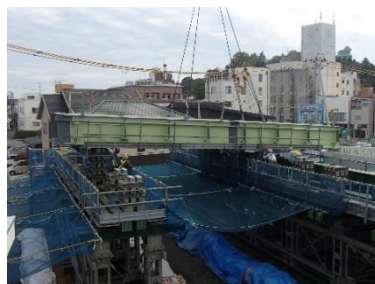
<橋桁架設状況>
