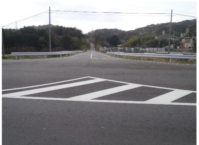
（四倉町玉山（道路終点部）実施状況） （農村整備部）
