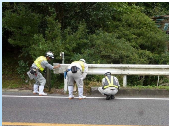
路面の損傷確認状況
