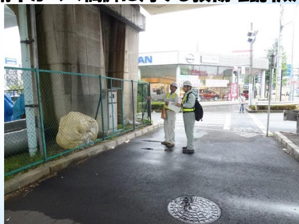
桁下からの橋脚に対する損傷確認状況
