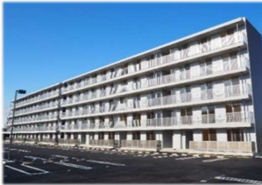
福島県復興公営住宅 富田団地 1 号棟
