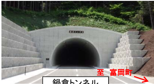
鍋倉トンネル
