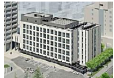
危機管理センターが整備される県庁北庁舎
