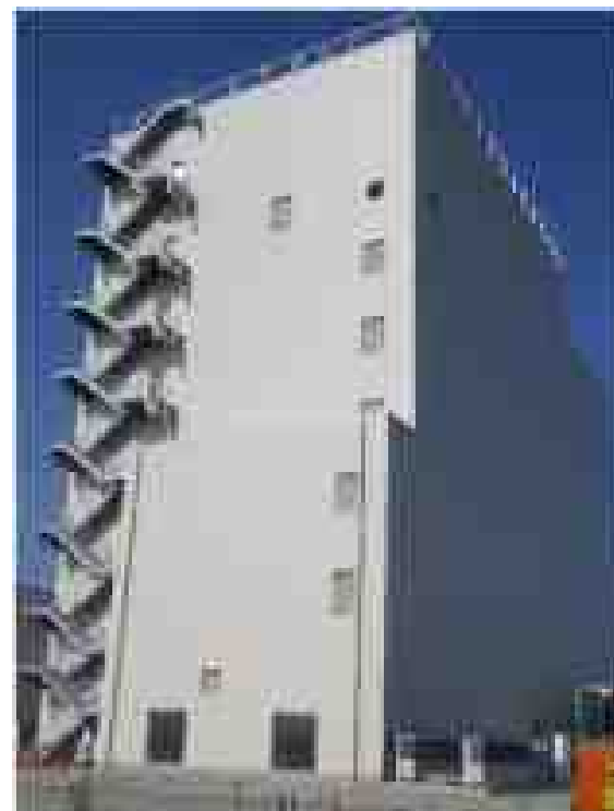
大型休憩所（外観）
