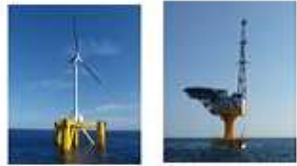
2MW風車 「ふくしま未来」 洋上変電所 「ふくしま絆」
