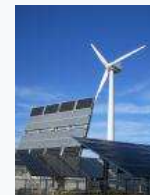
産総研福島再生可能エネルギー研究所の風車と追尾式太陽光パネル
