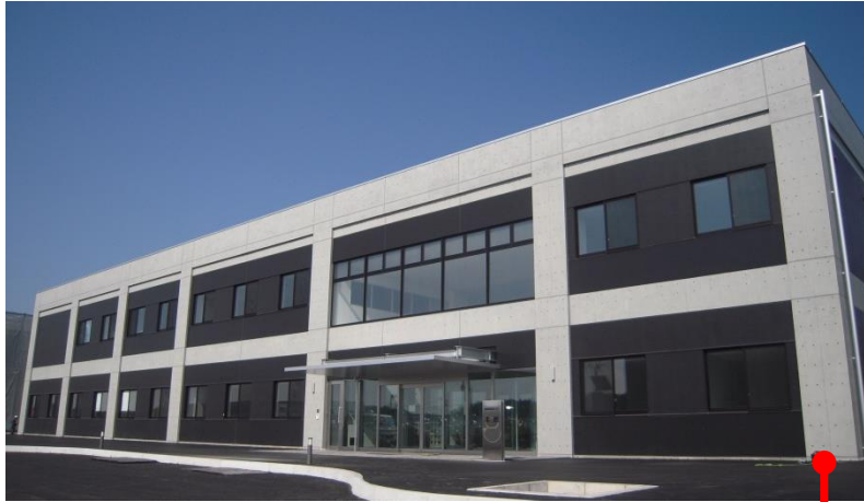
環境創造センター本館（三春町）
