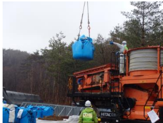
フレキシブルコンテナ内の土壌改質作業
