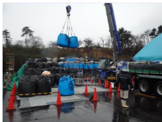
除去土壌等の積下ろし作業
