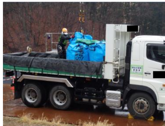
除去土壌等の積み込み作業
