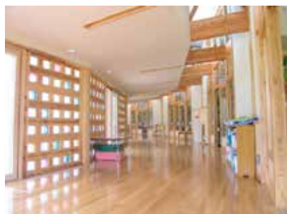
写真5-24 採光や通風が可能な多機能耐力壁
