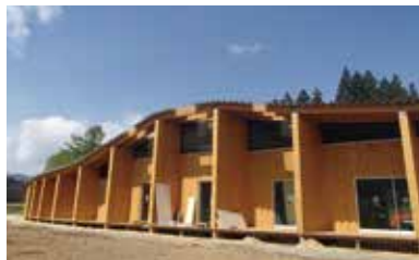
写真5-26 縦ログ工法による建物
