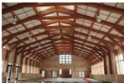
写真5-22 木質ラーメン工法で建てられた大規模建築物
