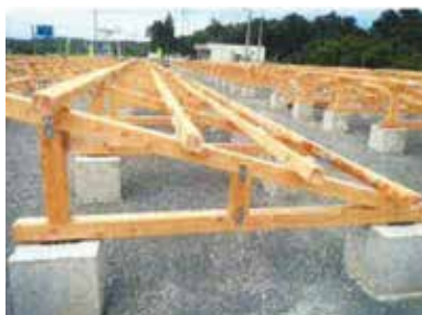
写真5-27 調練場西発電所に設置された木製架台
