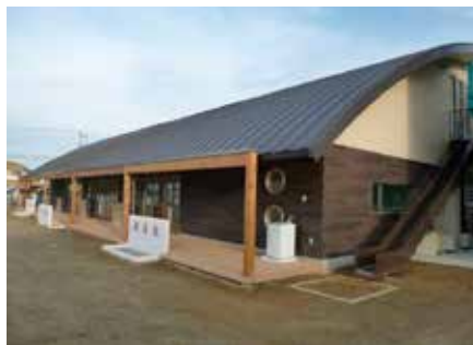
写真5-11 大倉保育園 (いわき市)
