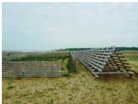
写真5-1 間伐材を使用して 作られた静砂垣及 び防風柵
