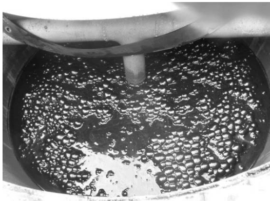
図-8 排煙処理装置水タンク内の汚染水
