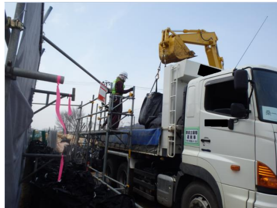
除去土壌等の積み込み作業
