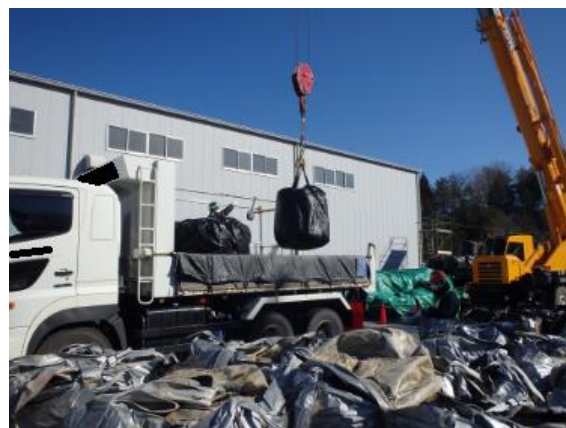
除去土壌等の積下ろし作業
