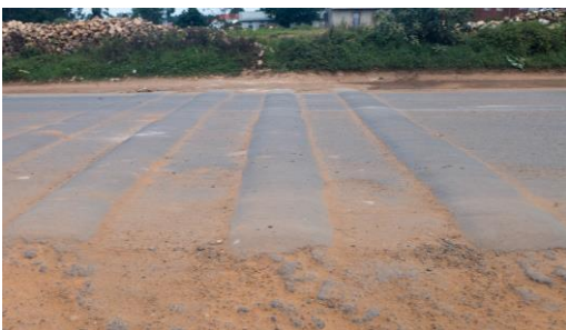
ウガンダには信号はほとんど無く、ハンブ(バンブ)と呼ばれるスピードを落とすための起伏が道路にあります。
