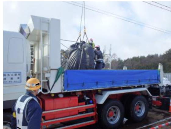
除去土壌等の積み込み作業
