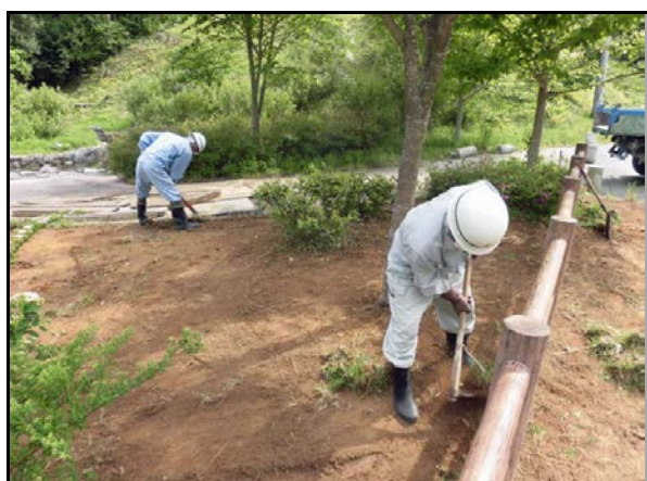
除染作業状況(公園施設)
