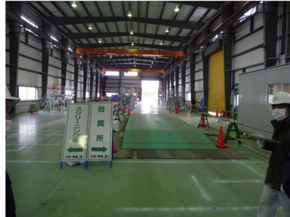
輸送車両の重量測定機器設置の確認
