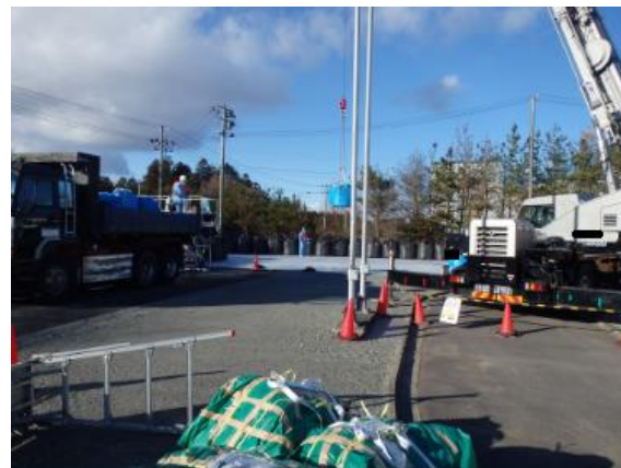
除去土壌等の積下ろし作業
