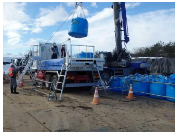
除去土壌等の積み込み作業
