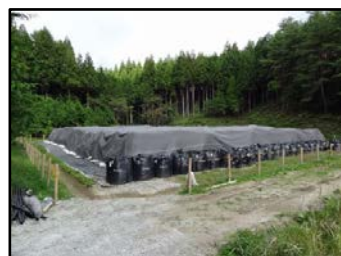
キャッピング完了後
