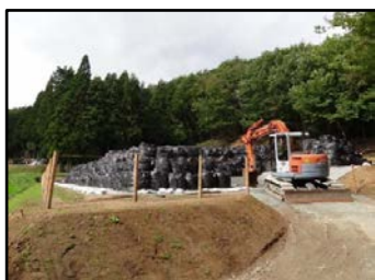
通気性防水シートキャッピング前
