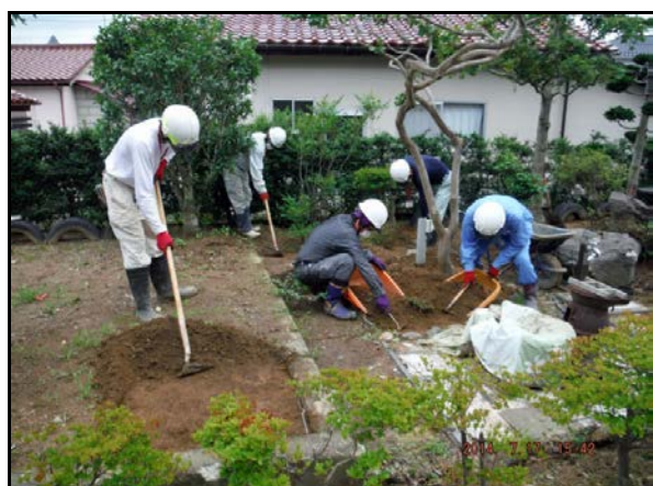
除染作業(表土除去作業)
