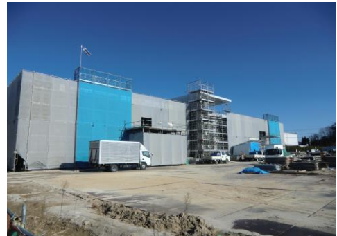
三春町施設交流棟(コミュタン福島) 工事の様子 (平成27年12月18日現在)
