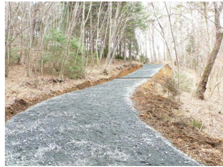
作業道の完成状況（いわき市）
