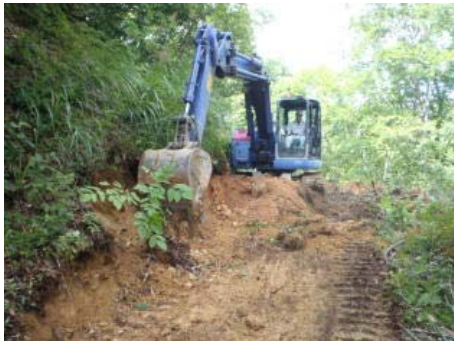
作業道の作設状況（柳津町）
