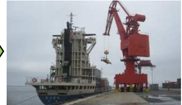
小名浜港大剣ふ頭岸壁（いわき市泉町下川地内）
