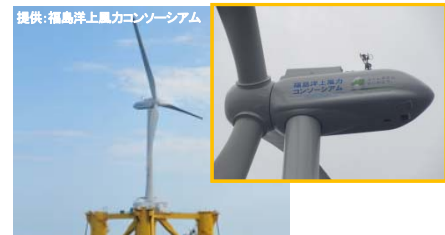
浮体式洋上風力発電実証研究事業
