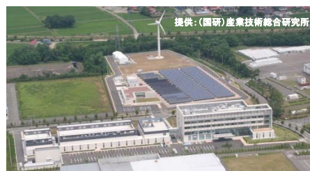
福島再生可能エネルギー研究所
