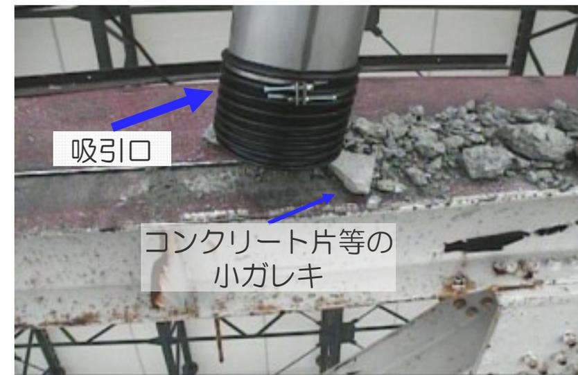
既存鉄骨梁上のコンクリート片等の小ガレキ吸引作業の様子（H27年11月19日撮影）
