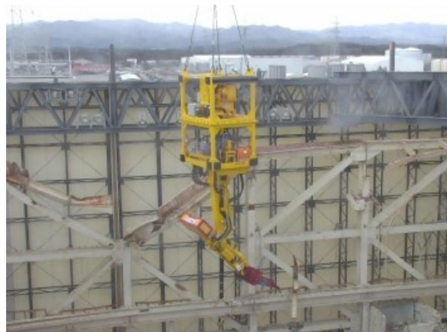
支障鉄骨等撤去装置 通信確認状況写真
