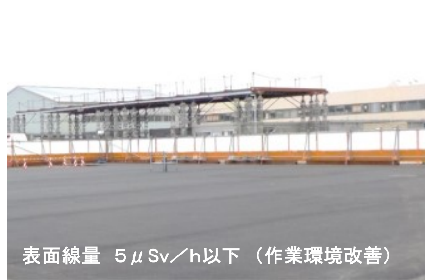
【写真②(35m盤)】北側エリア:免震棟前舗装後
