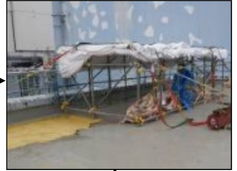
【写真⑧】仮設テント盛替状況 (4月1日)
