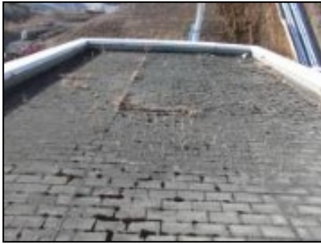
【写真①】作業前
