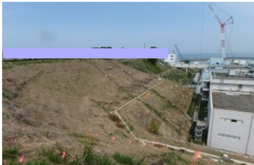
【写真①(35m盤)】北側エリア:モルタル吹付施工前
