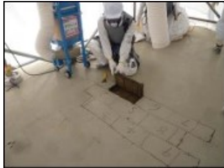
【写真⑤】汚染源撤去開始 (3月30日)
