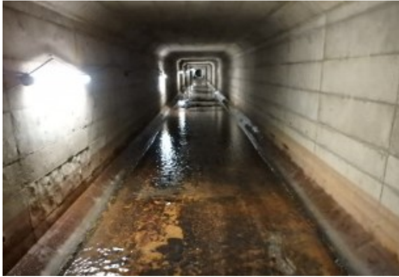
【写真②】K排水路暗渠内部(清掃完了)
