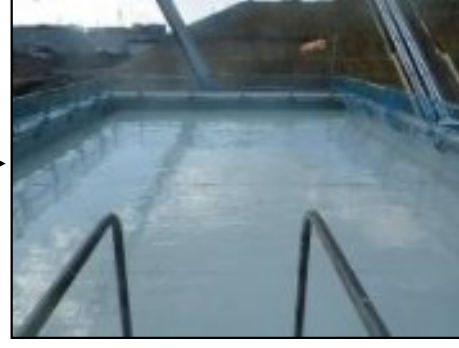
【写真③】ウレタン防水完了 (3月14日)
