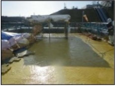
【写真⑨】ストリップابلペイント塗布状況 (4月2日)
