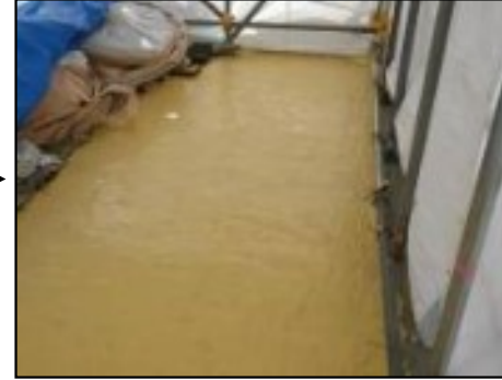
【写真⑦】仮設テント内ストリップابلペイント塗布状況 (3月31日)
