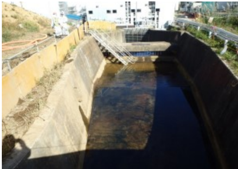
【写真①】大芋沢～K排水路暗渠接続部(清掃完了)
