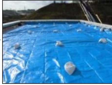
【写真②】ブルーシート設置 (3月2日)
