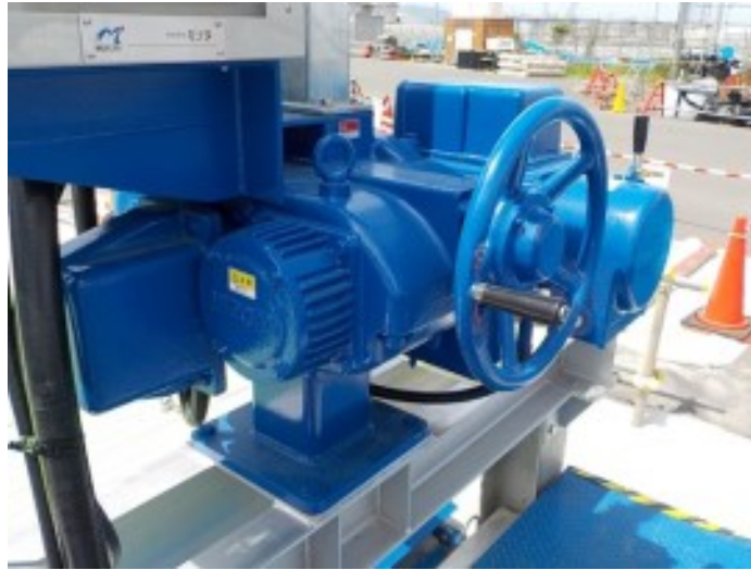
写真 ゲート巻上機電動化状況
