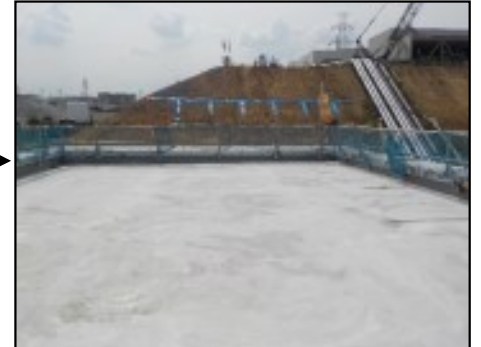
【写真⑫】押さえモルタル打設 (5月28日)
