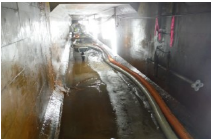
【写真②】K排水路暗渠内部(清掃前)
