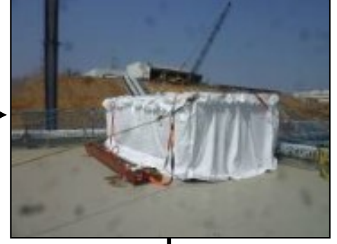
【写真④】仮設テント設置完了 (3月31日)
