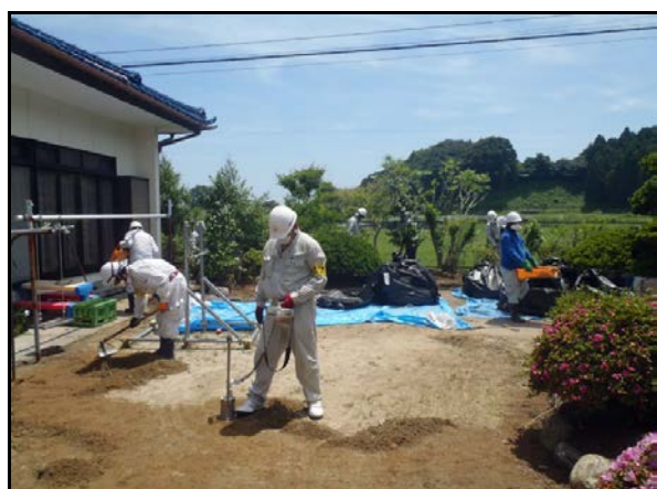
家屋除染作業 (H24当時)
