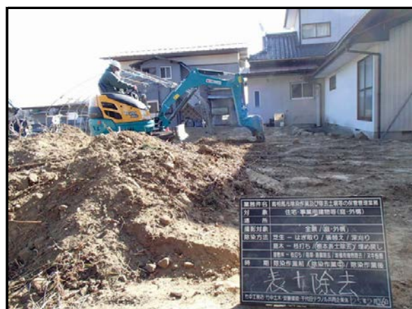
庭除染作業中
