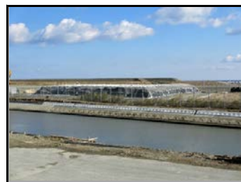
土のう設置状況
