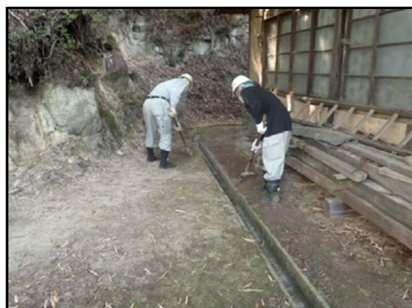
除染実施状況
