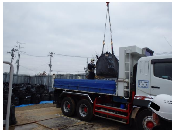
除去土壌等の積み込み作業
