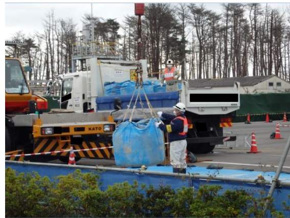
除去土壌等の積替え作業
