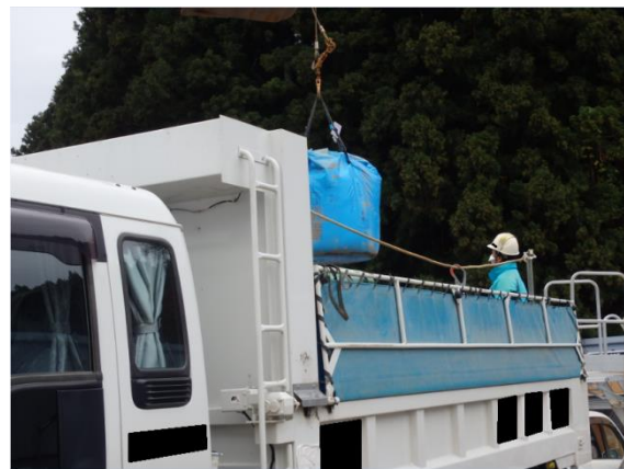
除去土壌等の積み込み作業
