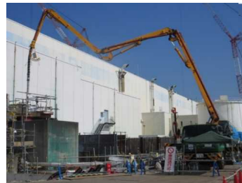
<トレンチ内部充填・閉塞の状況>
