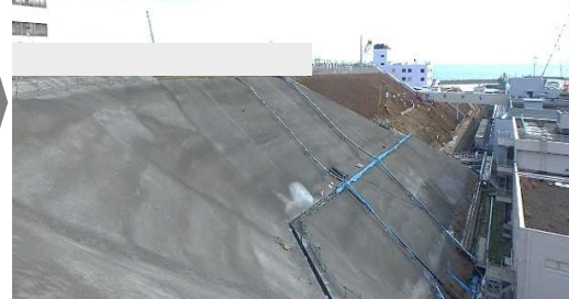
<35m盤 北側エリア：モルタル吹付施工状況>
