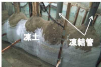
凍結管周囲の土が凍り始める
