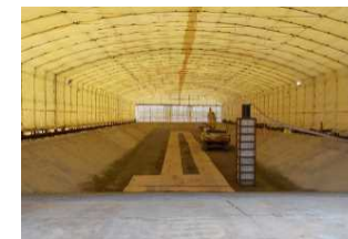
覆土式一時保管施設第3槽全景
