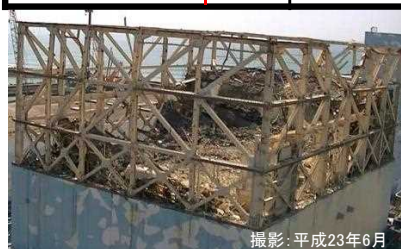
建屋カバー設置前の状況
