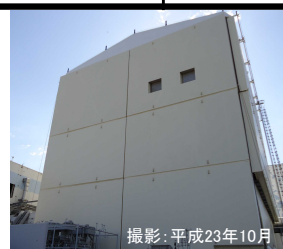
建屋カバーの設置状況
