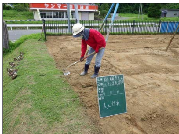
校庭除染工事表土剥取
