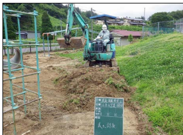
校庭除染工事表土剥取
