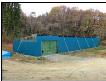
石川町仮置場
