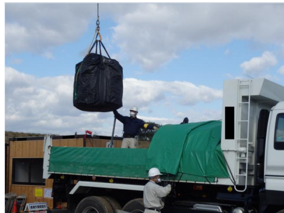
除去土壌等の積み込み作業
