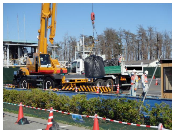
除去土壌等の積替え作業
