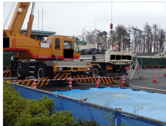
除去土壌等の積替え作業
