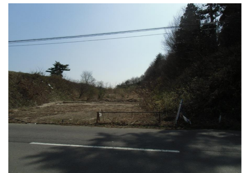
写真3. バイパス部改良状況(須賀川市大久保付近)
