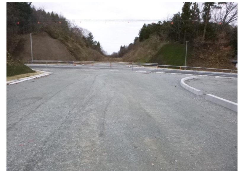
写真2. バイパス部改良状況(須賀川市大久保付近)
