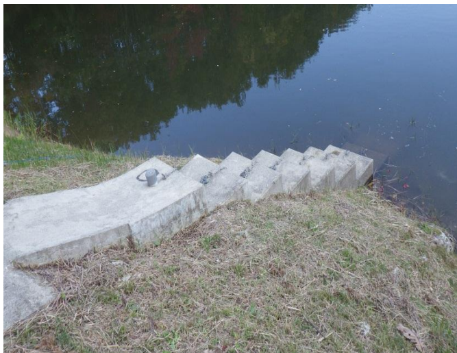
集落の方々が工事した斜樋(しゃひ)。 業者ではなく、農家の方々によるものだと聞いた委員 は驚きを隠せなかった。
