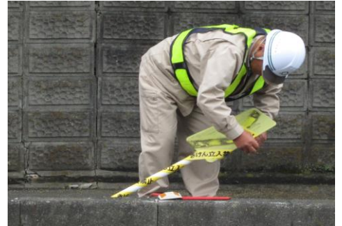
応急補修作業
