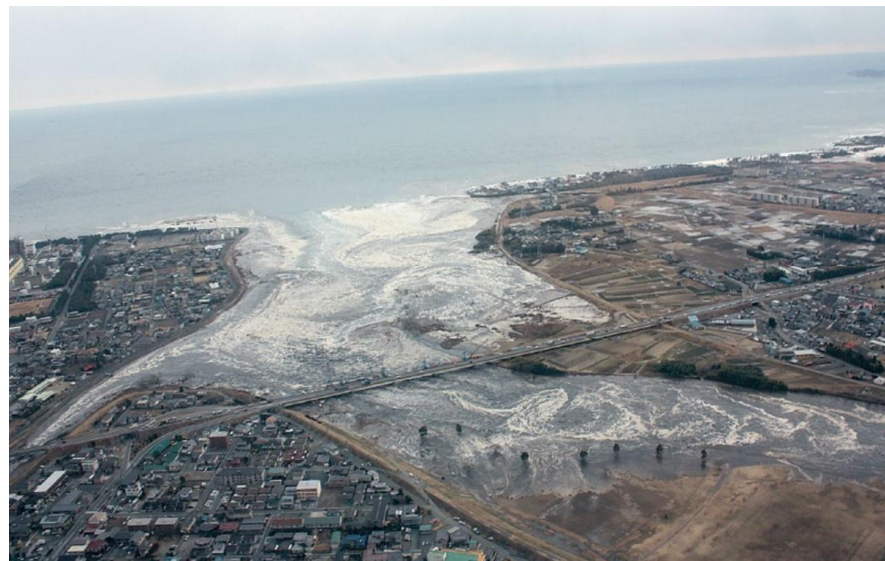
いわき市鮫川河口周辺（平成23年3月11日）
