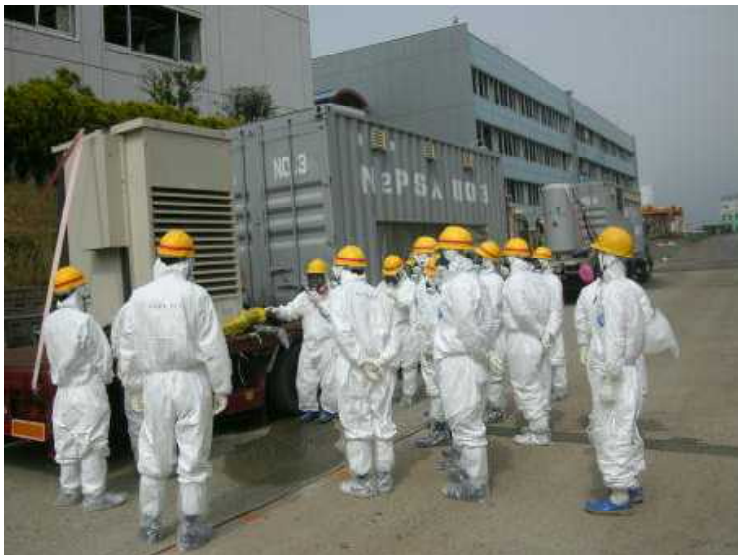
・窒素ガス分離装置
